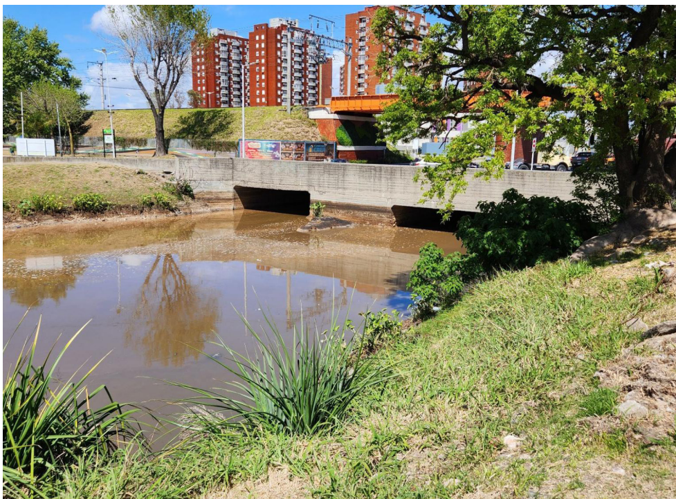
Figura 12: Salida del entubado sobre el arroyo Sarandí
