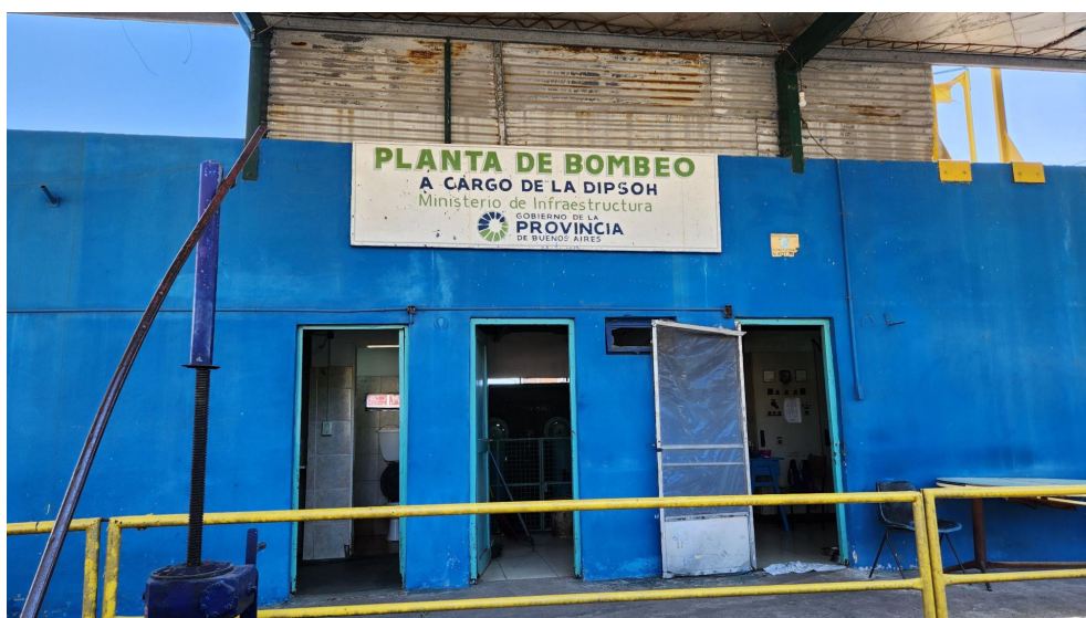
Figura 14: Estación de bombeo Olmos, sobre el arroyo Santo Domingo (Avellaneda).
